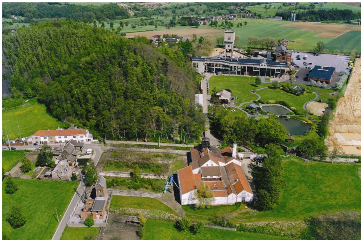
Vue d'ensemble, orientée ouest-est, du site de Blegny-Mine (ancien site du charbonnage d'Argenteau). A l'avant-plan, le puits Marie et, derrière, les installations du puits N°1. Coll. Blegny-Mine.
