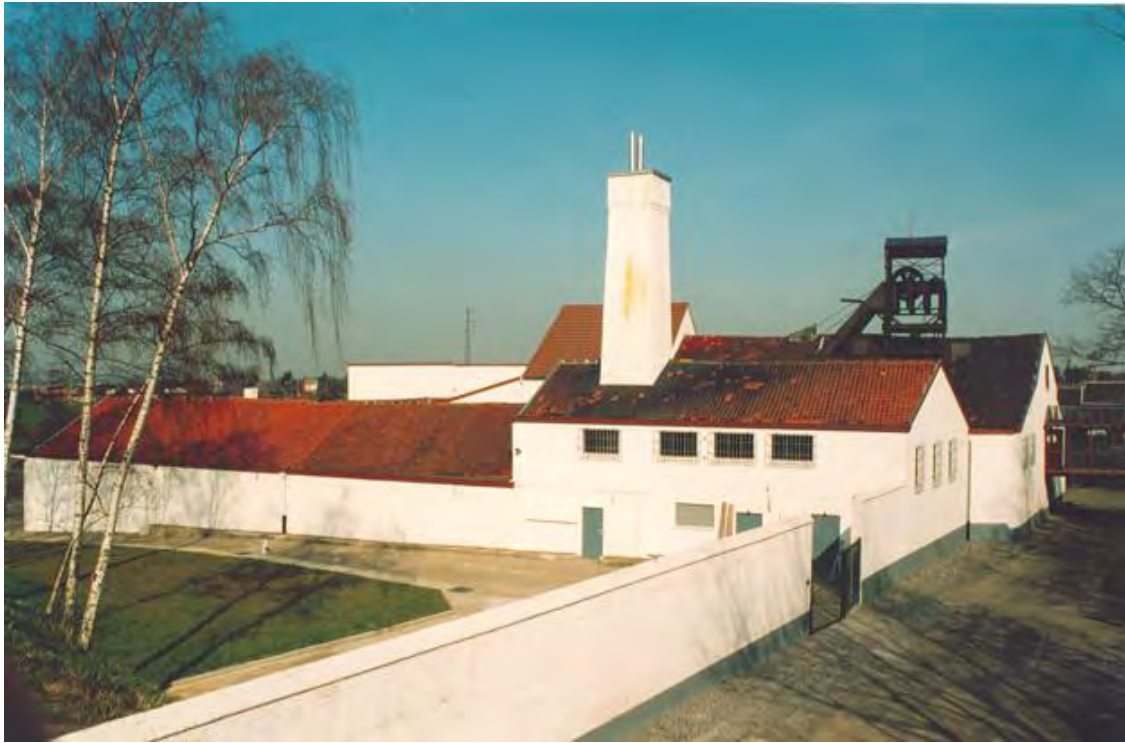
Façades sud et est du puits Marie après rénovation en 1993. Coll. Blegny-Mine.
