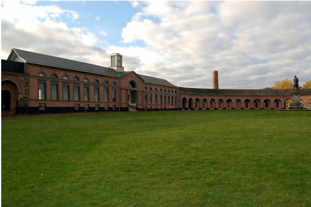
Vue de la Maison des Ingénieurs depuis la cour ovale (Photo Georges Fessy).
