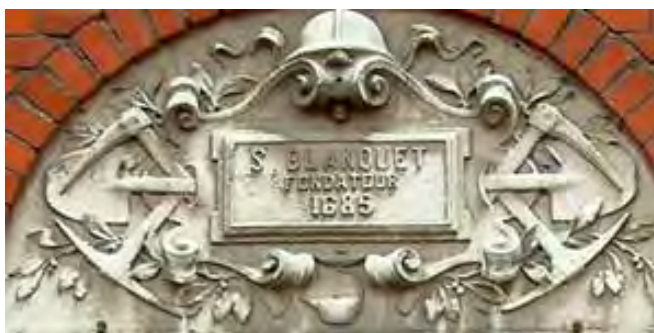
Tympan de l'une des baies de l'aile des bureaux conçus par l'architecte bruxellois Charles-Emile Janlet en 1907. (Photo R. Willame)
