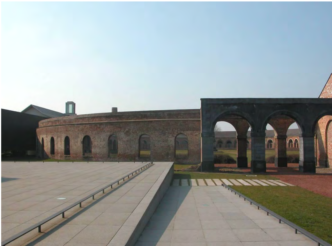
Vue des arcades du Grand-Hornu depuis la terrasse arrière du MAC's
