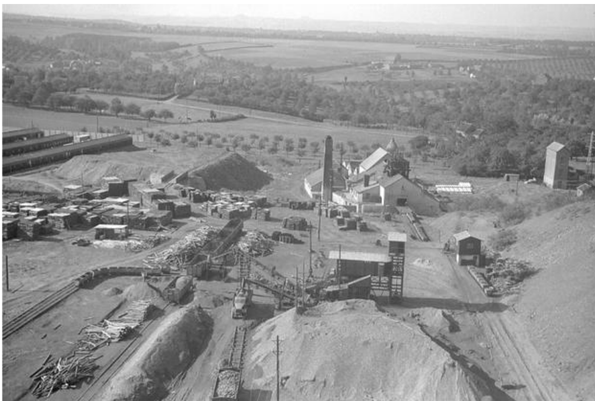
Vue d'ensemble du terrain du puits Marie prise de la tour du puits N°1. On distingue au fond à gauche les trois baraquements installés en 1947. En ce qui concerne le bâtiment du puits proprement dit, on remarque les modifications apportées à la cheminée et au bâtiment se trouvant juste derrière. Coll. Blegny-Mine.
