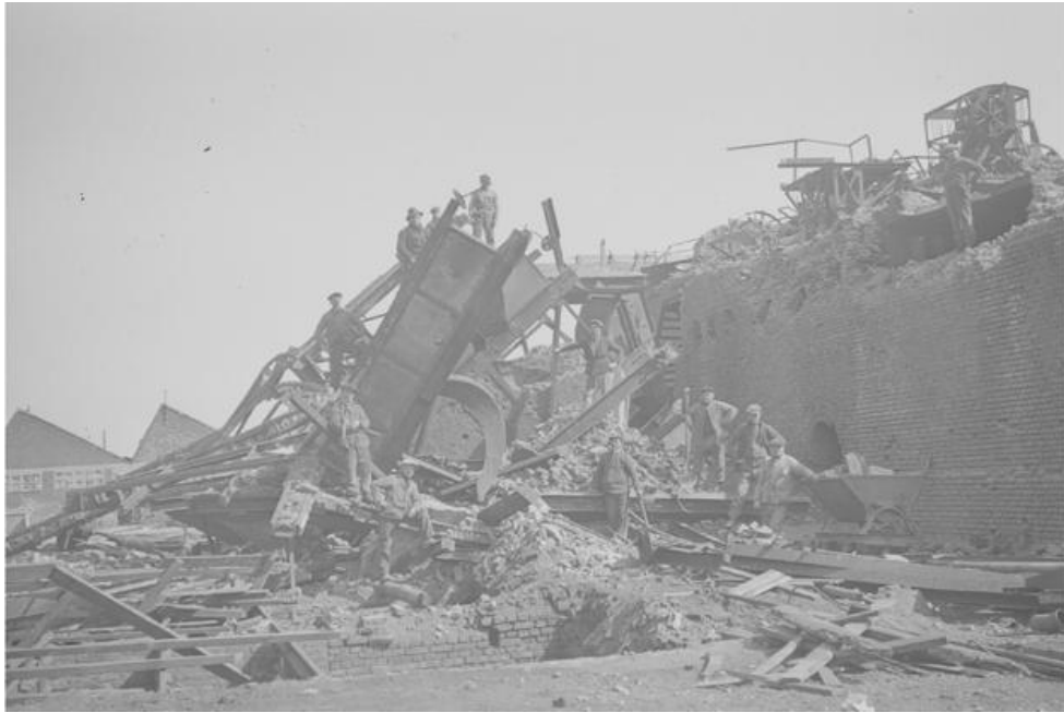
Décombres du lavoir. Cliché pris le 8 avril 1941.Fonds Ausselet. Collection Blegny-Mine.
